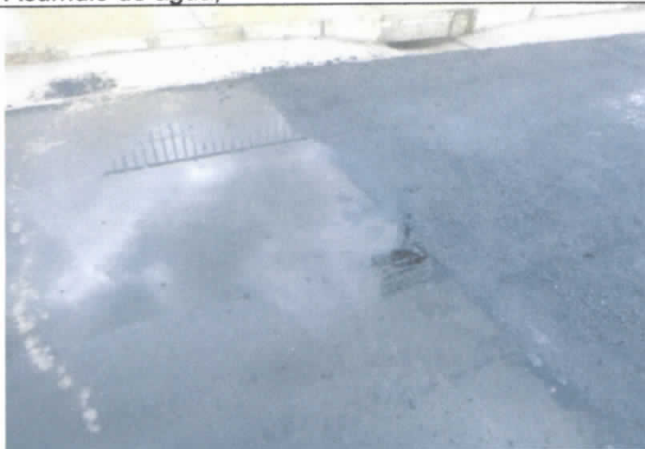
FOTO 15: Reparos no pavimento CBUQ - Desníveis em relação ao pavimento executado anteriormente – Acúmulo de água;
