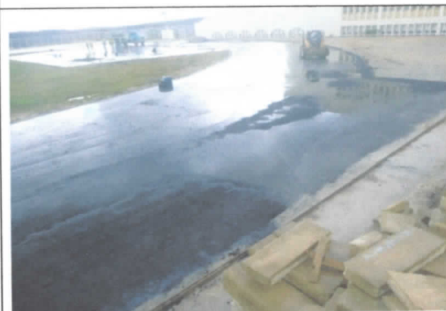
FOTO 12: Reparos no pavimento CBUQ - Desníveis em relação ao pavimento executado anteriormente - Acúmulo de água;
