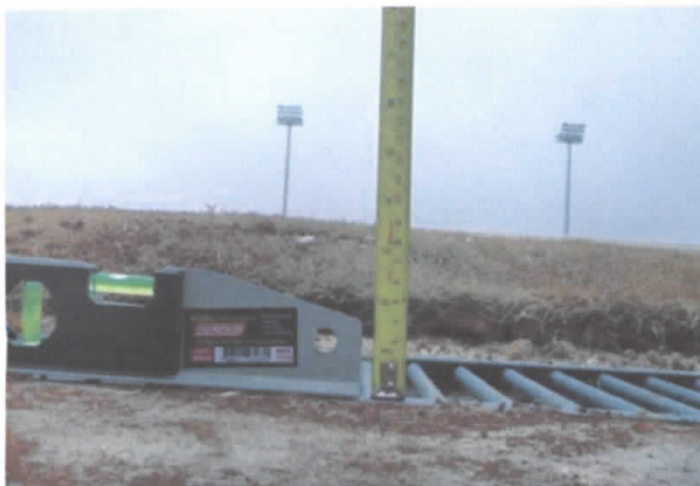
FOTO 73: Desnível entre o campo de futebol e a canaleta diferente do previsto em Projeto;
