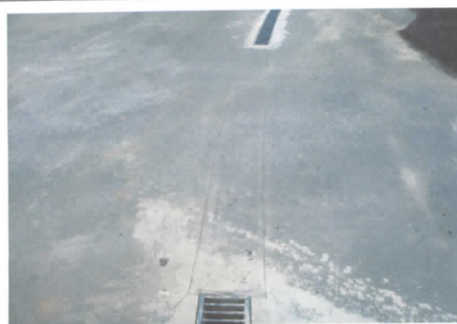
FOTO 23: Reparos no pavimento CBUQ - Desníveis em relação ao pavimento executado anteriormente;
