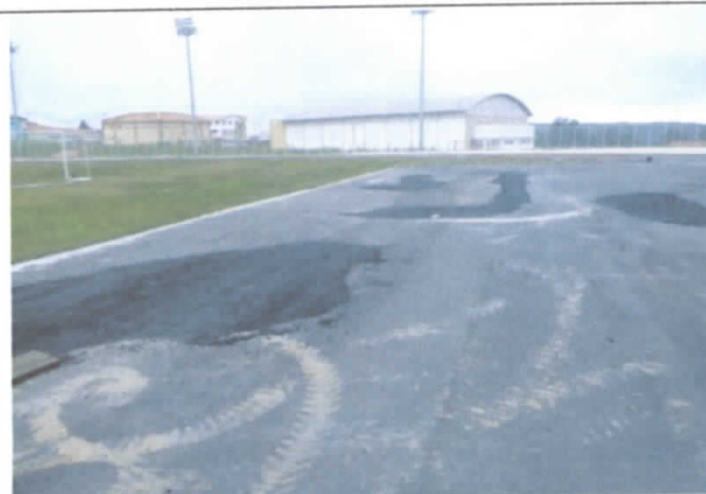
FOTO 05: Reparos no pavimento CBUQ - Desníveis em relação ao pavimento executado anteriormente;
