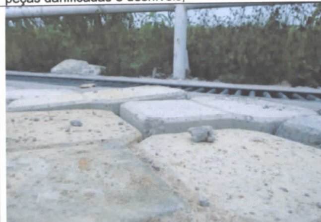
FOTO 41: Piso Inter travado faltando finalização, com peças danificadas e desníveis;
