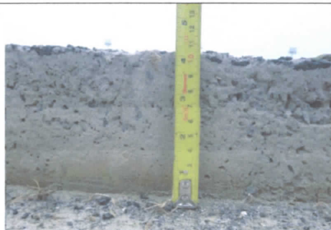
FOTO 64: Meio fio com altura diferente do previsto em projetos que é de 5 cm em relação ao piso Inter Travado;
