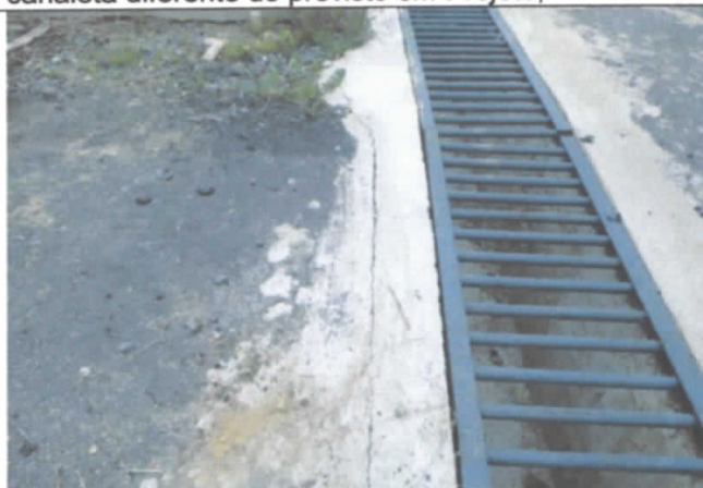
FOTO 77: Canaleta com bordas de concreto danificadas;
