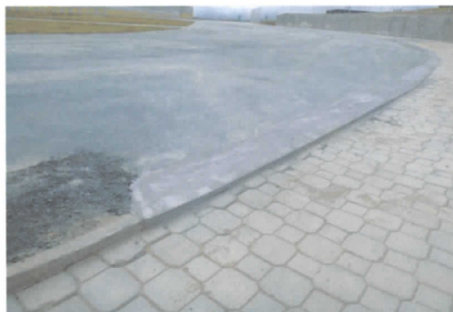
FOTO 44: Piso Inter travado faltando finalização, com peças danificadas e desníveis;
