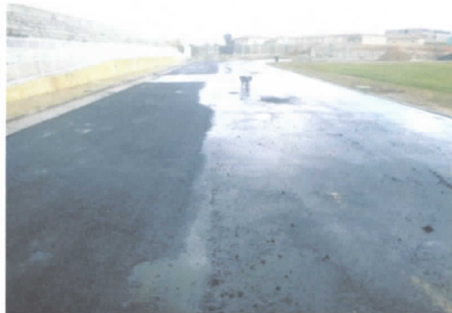
FOTO 14: Reparos no pavimento CBUQ - Desníveis em relação ao pavimento executado anteriormente – Acúmulo de água;
