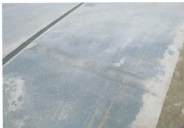
FOTO 24: Reparos no pavimento CBUQ - Desníveis em relação ao pavimento executado anteriormente;
