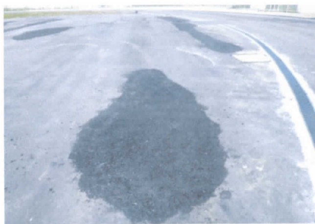
FOTO 04: Reparos no pavimento CBUQ - Desníveis em relação ao pavimento executado anteriormente;
