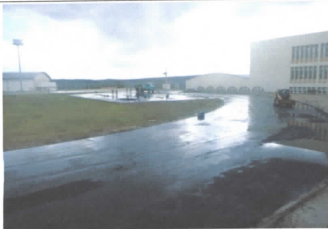
FOTO 19: Reparos no pavimento CBUQ - Desníveis em relação ao pavimento executado anteriormente - Acúmulo de água;
