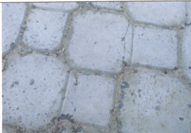
FOTO 29: Piso Inter travado faltando finalização, com peças danificadas e desníveis;
