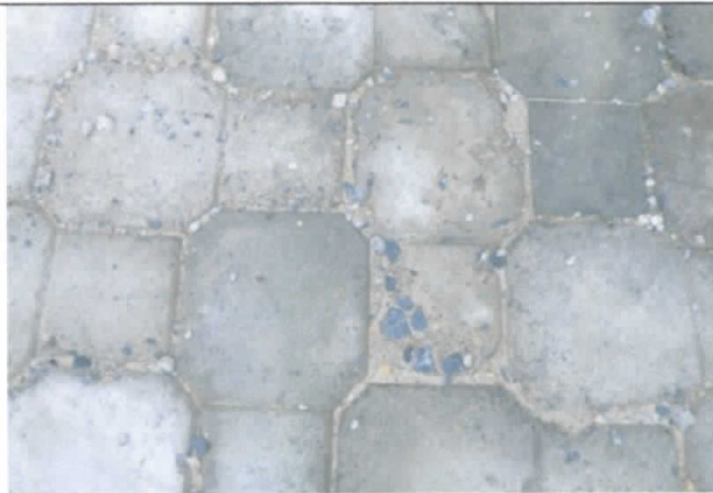
FOTO 32: Piso Inter travado faltando finalização, com peças danificadas e desníveis;
