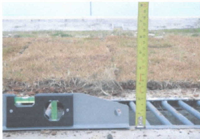
FOTO 74: Desnível entre o campo de futebol e a canaleta diferente do previsto em Projeto;
