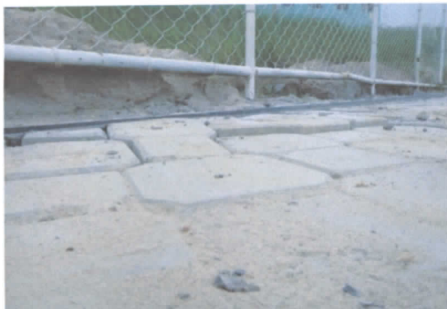
FOTO 43: Piso Inter travado faltando finalização, com peças danificadas e desníveis;
