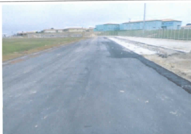
FOTO 07: Reparos no pavimento CBUQ - Desníveis em relação ao pavimento executado anteriormente;
