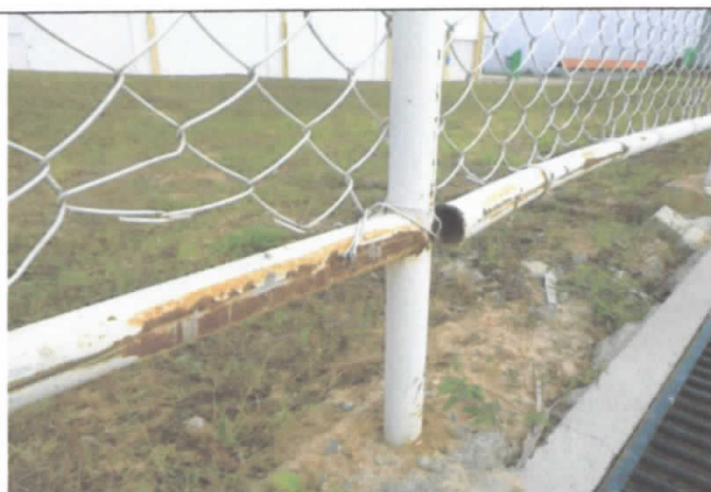
FOTO 81: Alambrado danificado e falha na pintura;
