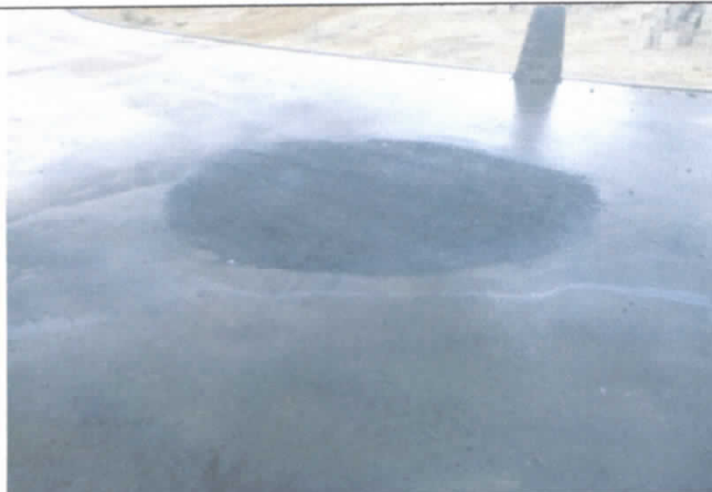
FOTO 17: Reparos no pavimento CBUQ - Desníveis em relação ao pavimento executado anteriormente – Acúmulo de água;
