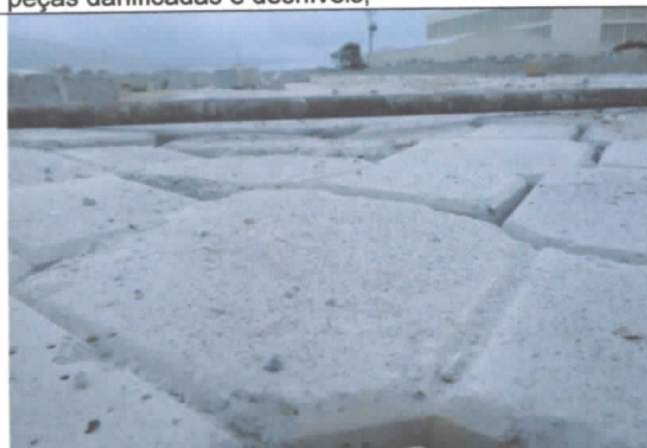
FOTO 39: Piso Inter travado faltando finalização, com peças danificadas e desníveis;
