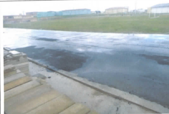
FOTO 11: Reparos no pavimento CBUQ - Desníveis em relação ao pavimento executado anteriormente - Acúmulo de água;
