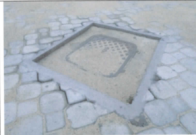
FOTO 36: Piso Inter travado faltando finalização, com peças danificadas e desníveis;
