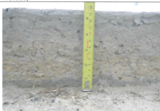
FOTO 66: Meio fio com altura diferente do previsto em projetos que é de 5 cm em relação ao piso Inter Travado;
