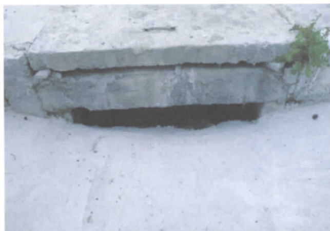
FOTO 62: Sarjeta com base de concreto danificada;
