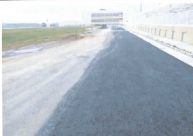
FOTO 03: Reparos no pavimento CBUQ - Desníveis em relação ao pavimento executado anteriormente;
