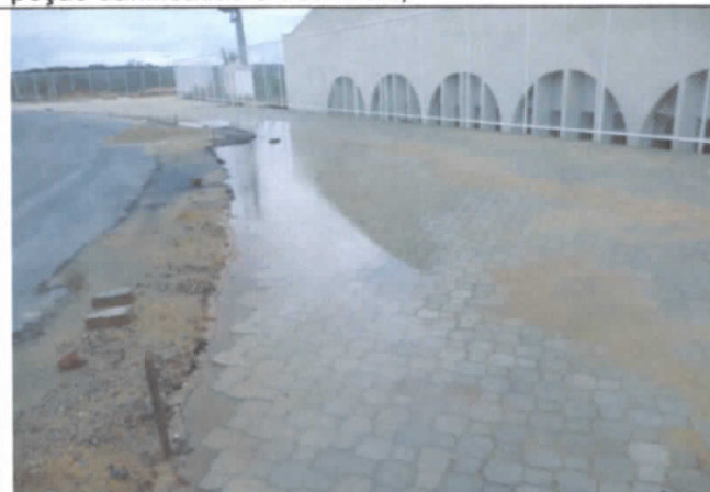
FOTO 46: Acúmulo de água entre a borda externa da Pista e o Piso Inter Travado;
