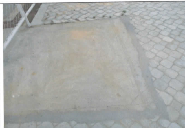
FOTO 35: Piso Inter travado faltando finalização, com peças danificadas e desníveis;
