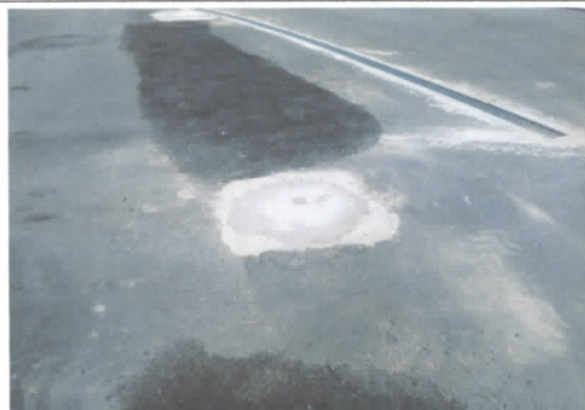
FOTO 22: Reparos no pavimento CBUQ - Desníveis em relação ao pavimento executado anteriormente - Acúmulo de água;
