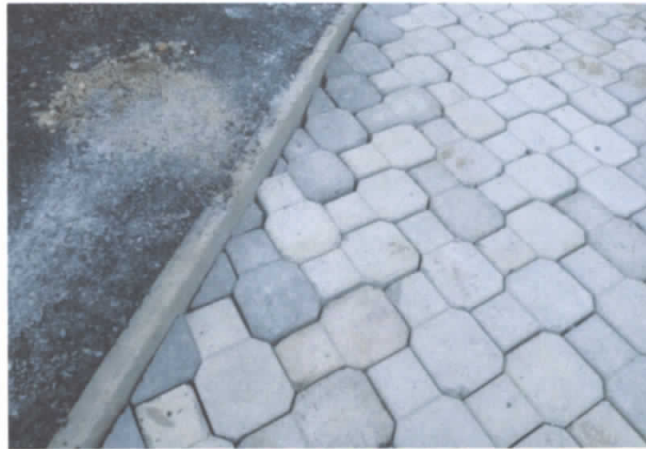
FOTO 38: Piso Inter travado faltando finalização, com peças danificadas e desníveis;
