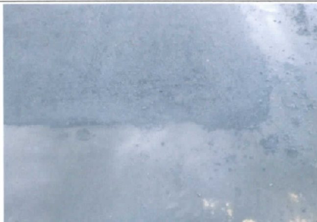
FOTO 20: Reparos no pavimento CBUQ - Desníveis em relação ao pavimento executado anteriormente - Acúmulo de água;
