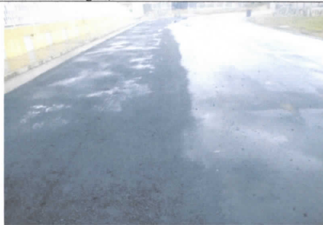
FOTO 16: Reparos no pavimento CBUQ - Desníveis em relação ao pavimento executado anteriormente – Acúmulo de água;
