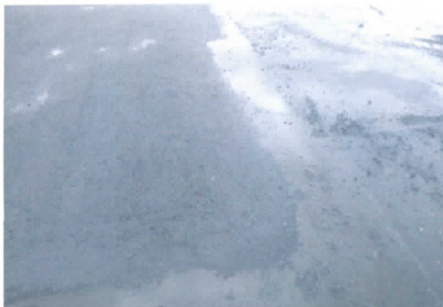
FOTO 13: Reparos no pavimento CBUQ - Desníveis em relação ao pavimento executado anteriormente – Acúmulo de água;
