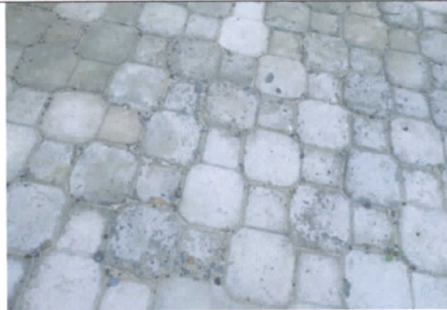
FOTO 34: Piso Inter travado faltando finalização, com peças danificadas e desníveis;
