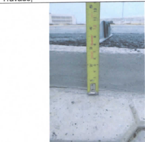
FOTO 53: Meio fio com altura diferente do previsto em projetos que é de 5 cm em relação ao piso Inter Travado;
