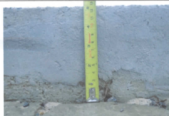
FOTO 54: Meio fio com altura diferente do previsto em projetos que é de 5 cm em relação ao piso Inter Travado;
