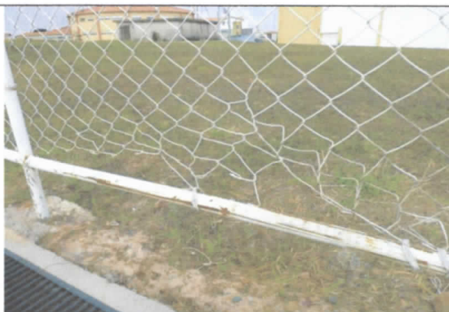
FOTO 82: Alambrado danificado e falha na pintura;
