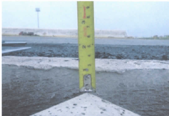
FOTO 50: Meio fio com altura diferente do previsto em projetos que é de 5 cm em relação ao piso Inter Travado;
