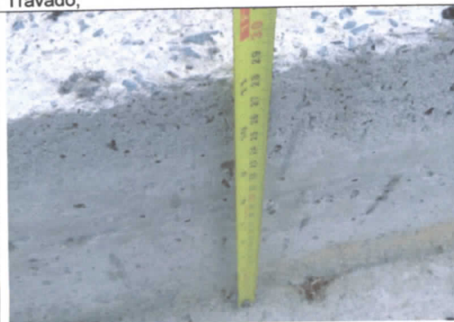
FOTO 59: Meio fio com altura diferente do previsto em projetos que é de 5 cm em relação ao piso Inter Travado;
