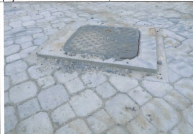
FOTO 40: Piso Inter travado faltando finalização, com peças danificadas e desníveis;
