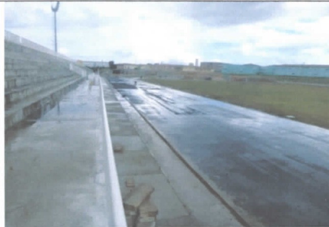
FOTO 18: Reparos no pavimento CBUQ - Desníveis em relação ao pavimento executado anteriormente – Acúmulo de água;
