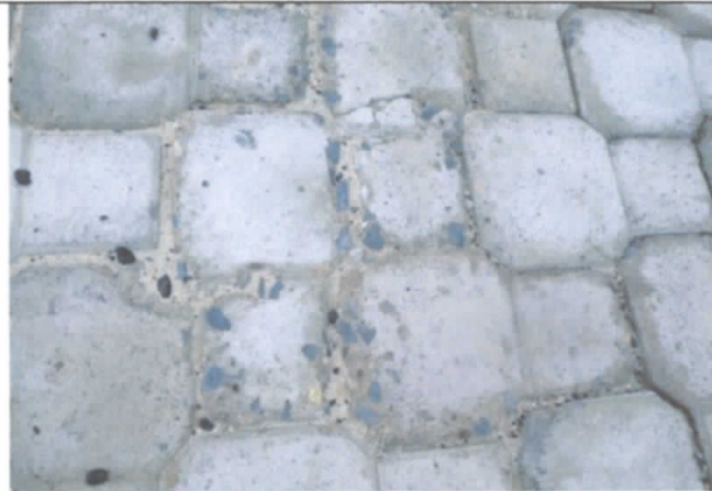
FOTO 30: Piso Inter travado faltando finalização, com peças danificadas e desníveis;
