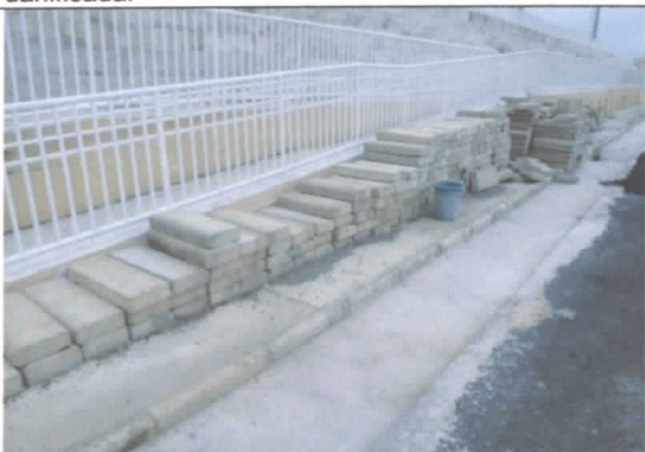
FOTO 71: Meio fio que foi retirado, sendo armazenado nas pendências da obra;
