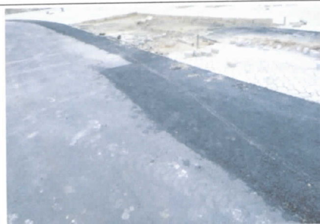
FOTO 09: Reparos no pavimento CBUQ - Desníveis em relação ao pavimento executado anteriormente;
