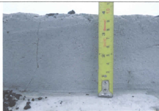
FOTO 52: Meio fio com altura diferente do previsto em projetos que é de 5 cm em relação ao piso Inter Travado;
