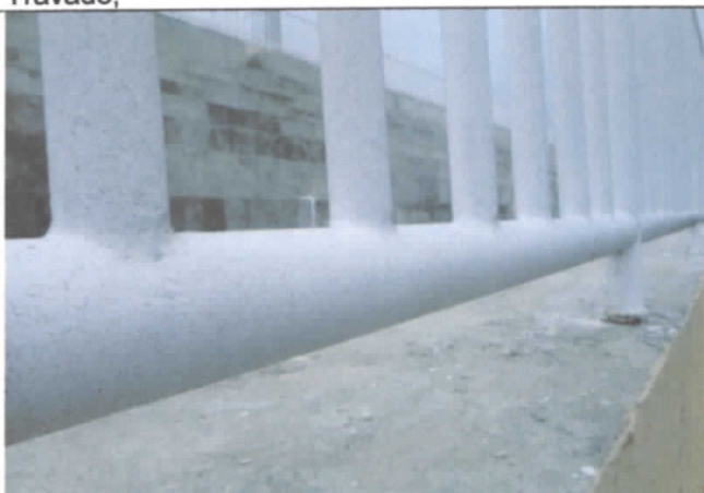
FOTO 69: Guarda corpo da arquibancada com pintura danificada;
