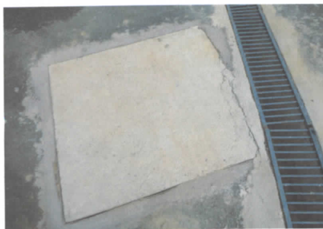
FOTO 21: Tampa danificada e acabamento ruim na caixa de drenagem;
