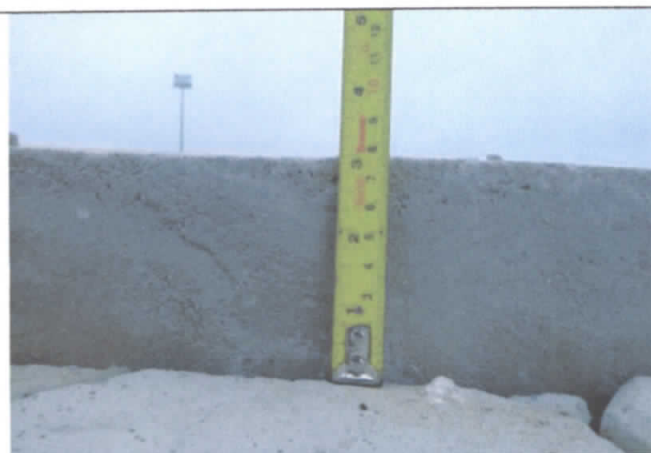
FOTO 51: Meio fio com altura diferente do previsto em projetos que é de 5 cm em relação ao piso Inter Travado;
