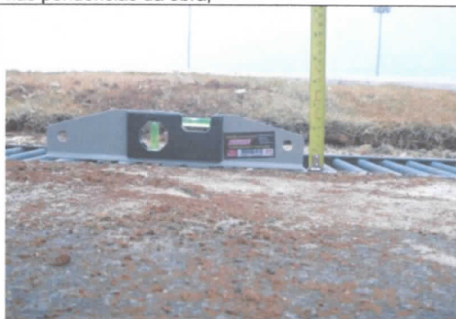
FOTO 72: Desnível entre o campo de futebol e a canaleta diferente do previsto em Projeto;
