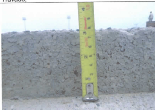
FOTO 57: Meio fio com altura diferente do previsto em projetos que é de 5 cm em relação ao piso Inter Travado;
