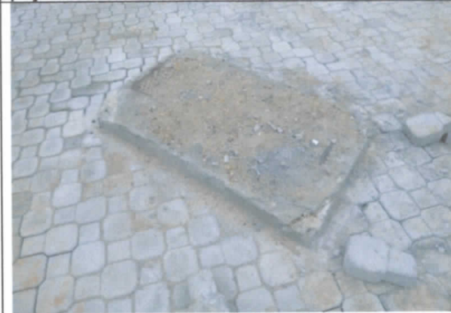
FOTO 42: Piso Inter travado faltando finalização, com peças danificadas e desníveis;
