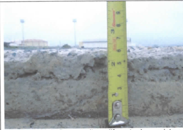
FOTO 60: Meio fio com altura diferente do previsto em projetos que é de 5 cm em relação ao piso Inter Travado;
