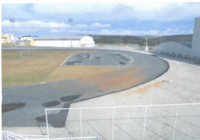
FOTO 25: Reparos no pavimento CBUQ – Desníveis em relação ao pavimento executado anteriormente;
