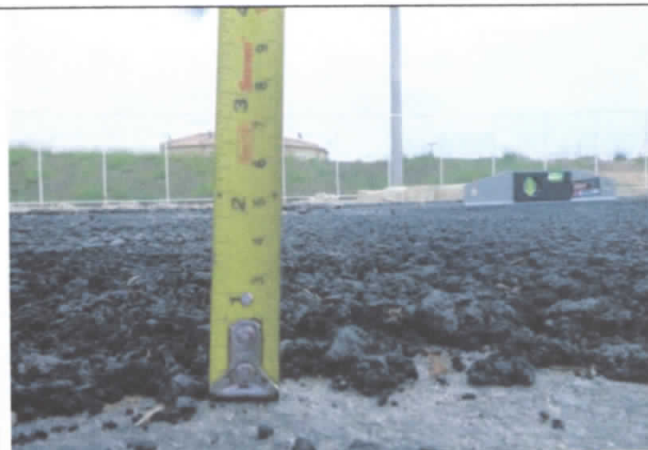
FOTO 10: Reparos no pavimento CBUQ - Desníveis em relação ao pavimento executado anteriormente;
