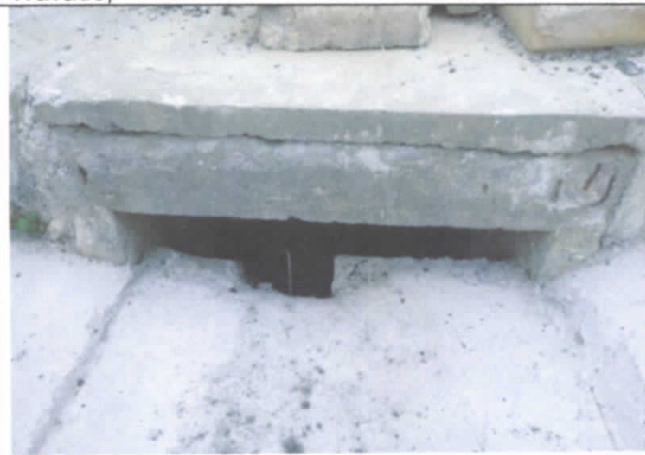
FOTO 58: Sarjeta com base de concreto danificada;
