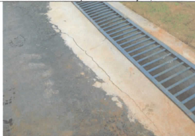
FOTO 78: Canaleta com bordas de concreto danificadas;
