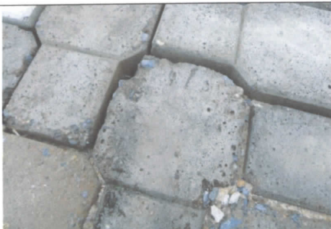
FOTO 31: Piso Inter travado faltando finalização, com peças danificadas e desníveis;
