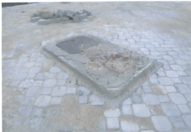
FOTO 37: Piso Inter travado faltando finalização, com peças danificadas e desníveis;
