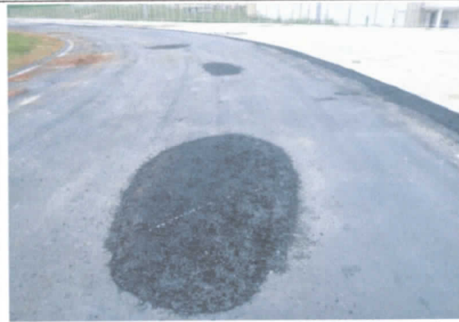
FOTO 06: Reparos no pavimento CBUQ - Desníveis em relação ao pavimento executado anteriormente;
