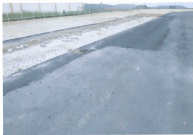
FOTO 08: Reparos no pavimento CBUQ - Desníveis em relação ao pavimento executado anteriormente;
