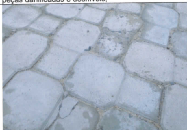
FOTO 45: Piso Inter travado faltando finalização, com peças danificadas e desníveis;
