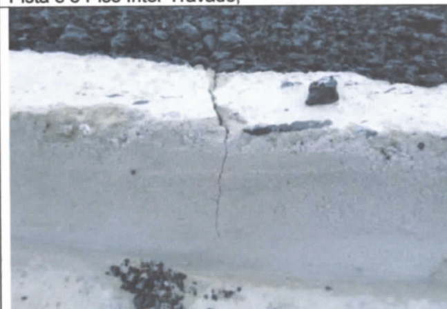
FOTO 48: Meio fio com Trincas e rachaduras;
