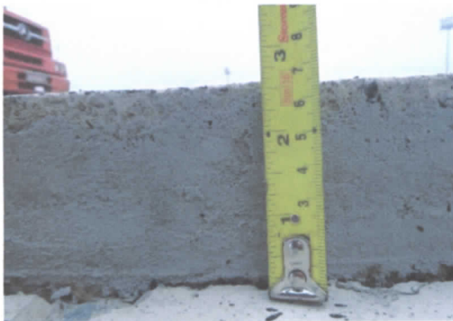
FOTO 55: Meio fio com altura diferente do previsto em projetos que é de 5 cm em relação ao piso Inter Travado;
