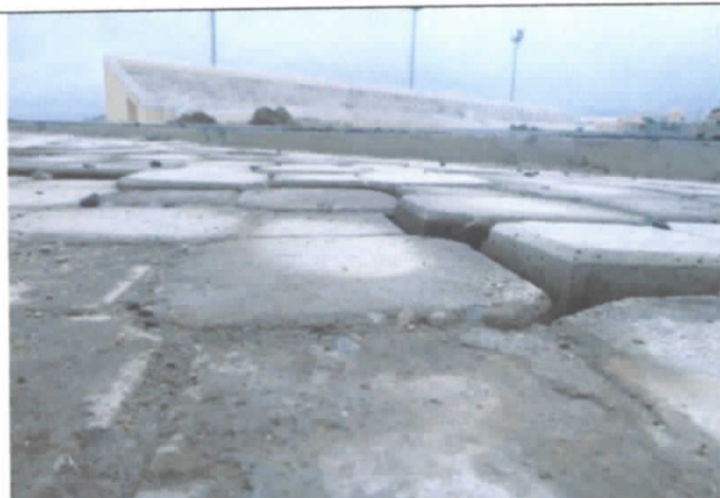
FOTO 33: Piso Inter travado faltando finalização, com peças danificadas e desníveis;
