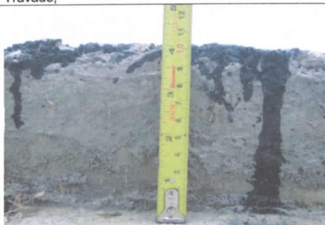
FOTO 65: Meio fio com altura diferente do previsto em projetos que é de 5 cm em relação ao piso Inter Travado;
