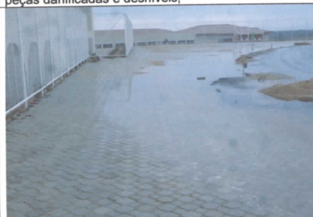
FOTO 47: Acúmulo de água entre a borda externa da Pista e o Piso Inter Travado;
