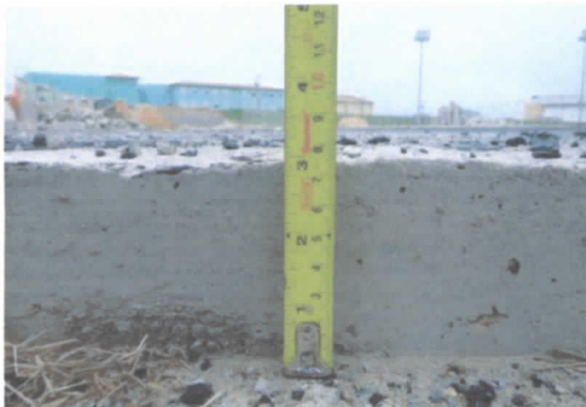
FOTO 67: Meio fio com altura diferente do previsto em projetos que é de 5 cm em relação ao piso Inter Travado;
