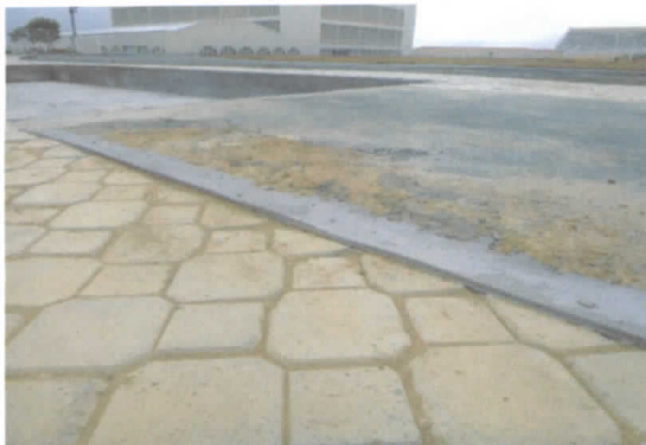
FOTO 49: Meio fio com altura diferente do previsto em projetos que é de 5 cm em relação ao piso Inter Travado;
