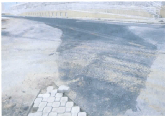
FOTO 01: Reparos no pavimento CBUQ - Desníveis em relação ao pavimento executado anteriormente;
