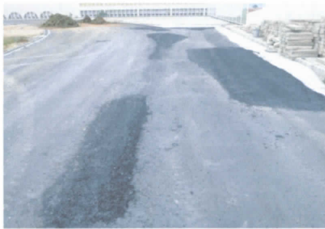
FOTO 02: Reparos no pavimento CBUQ - Desníveis em relação ao pavimento executado anteriormente;
