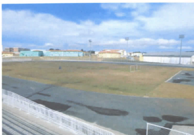
FOTO 27: Reparos no pavimento CBUQ - Desníveis em relação ao pavimento executado anteriormente;
